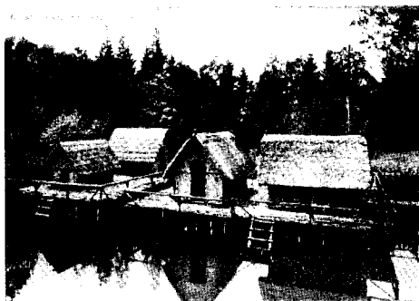
Ricostruzione di villaggio palafitticolo svizzero secondo la teoria del Keller (1860 circa).
